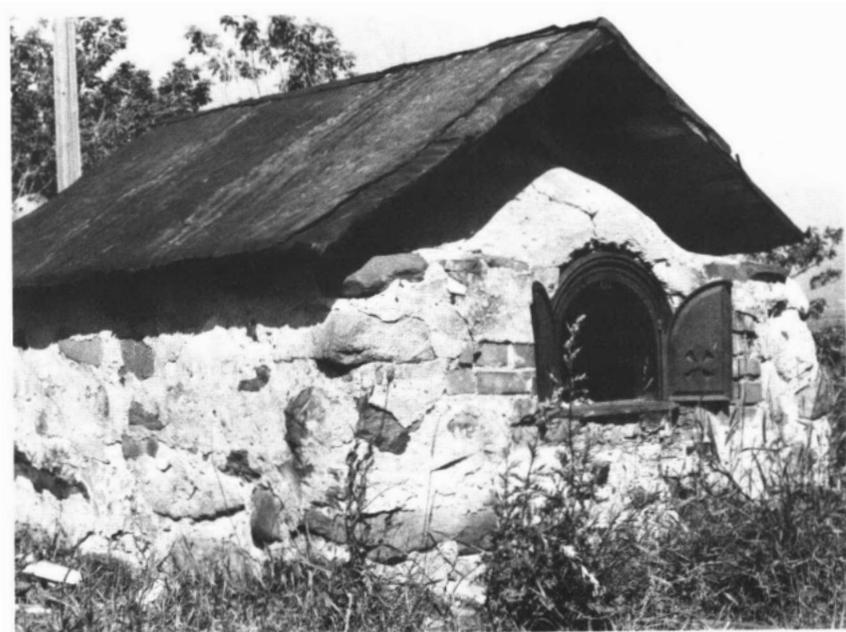
Four avec voûte en briques dont les côtés sont protégés par une maçonnerie de pierres des champs liées par du mortier.
