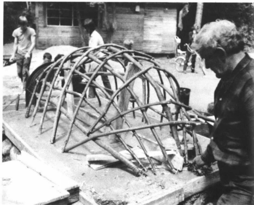
Le support à claire-voie laisse entrevoir la coupe finale du four. Collection Lise et Jean-François Blanchette
