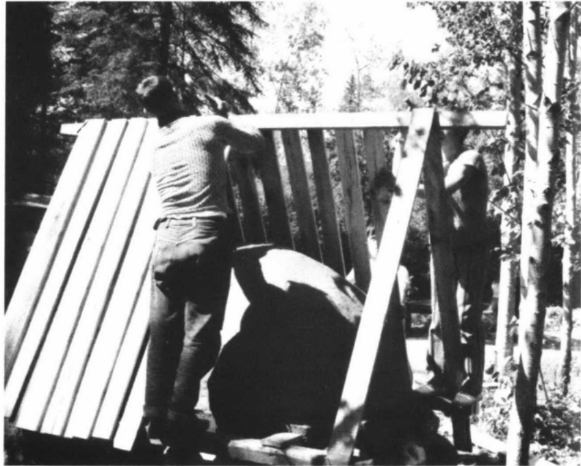
Construction de l'abri. Collection Lise et Jean-François Blanchette
