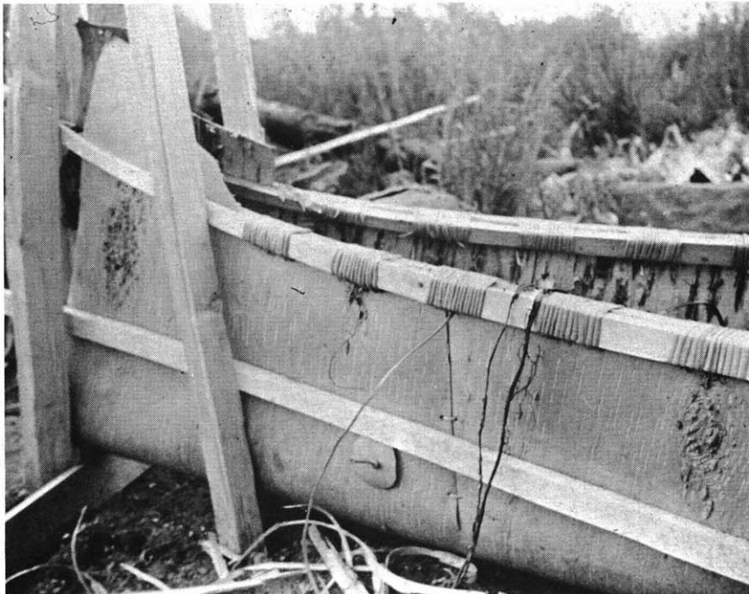
C. Séquences de façage. Noter la rondelle de retenue utilisée pour arquer les lisses
