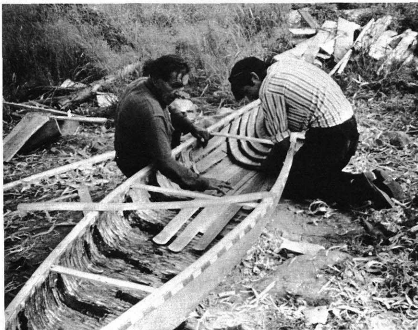
PLANCHE XXI Pose du bordé et des varangues
