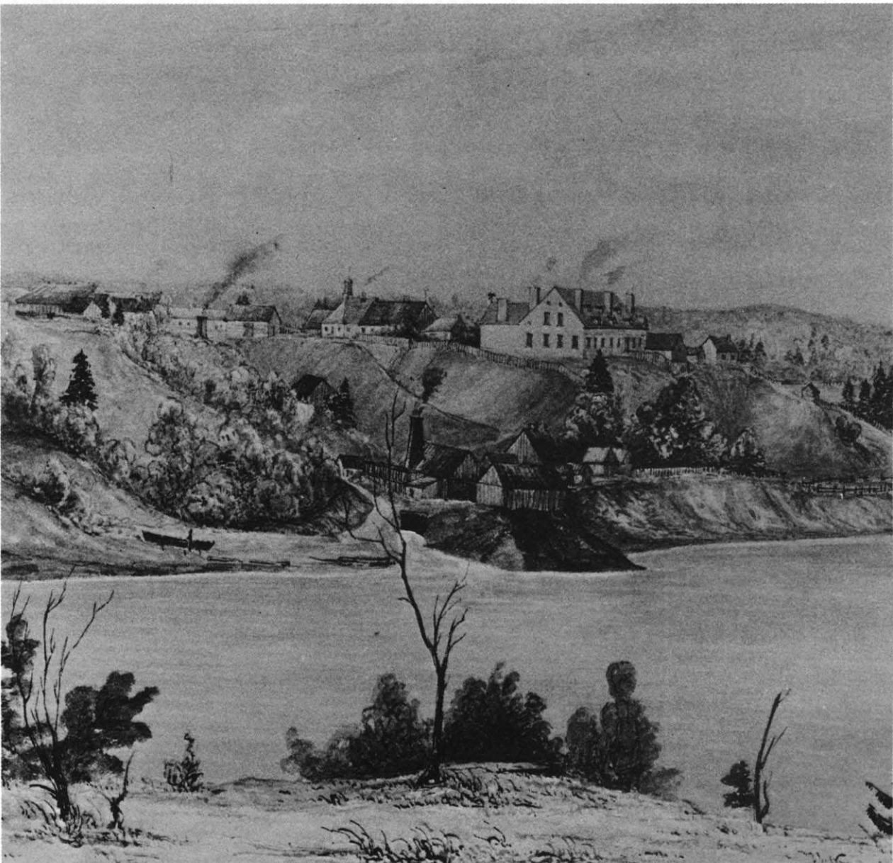
Une aquarelle des forges St. Maurice en 1844 (Archives publiques du Canada)
